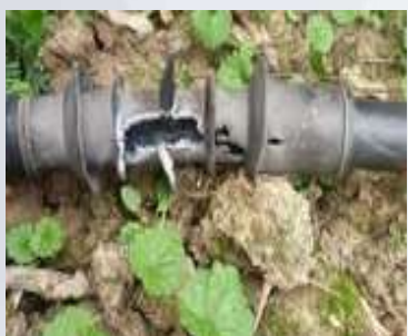
电缆终端 局放定 位
