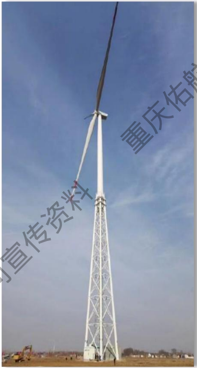
预应力钢管混凝土格构式塔架
