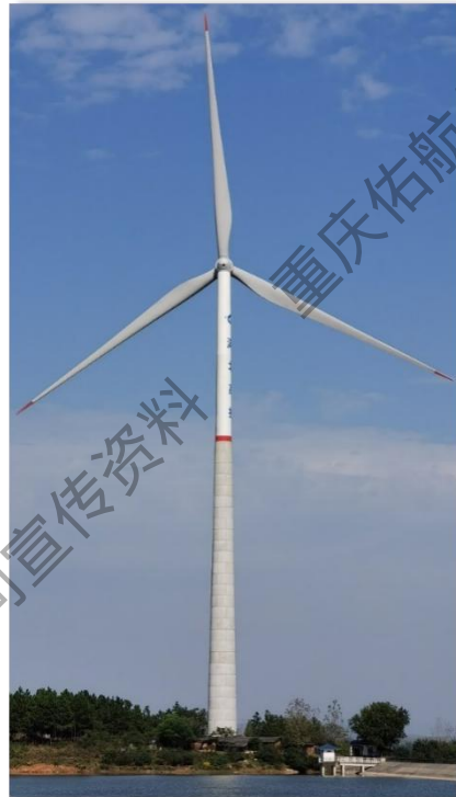
钢-预应力混凝土混合结构塔筒
