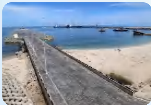
毛里塔尼亚友谊港工程
