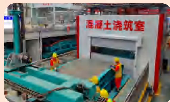
混凝土浇筑室
