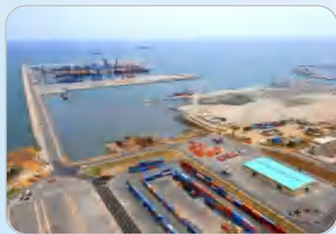
赤道几内亚巴塔港工程
