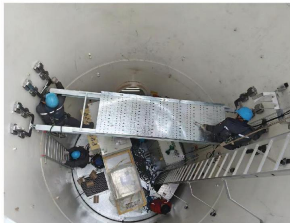
▲ fixing new platform 磁吸固定新平台
