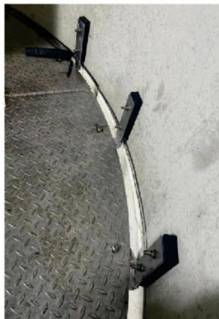
▲ reinforce platform 磁吸加固平台
