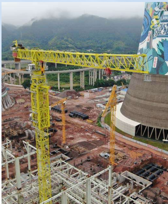
JLP系列平头塔机进行火电机组施工
