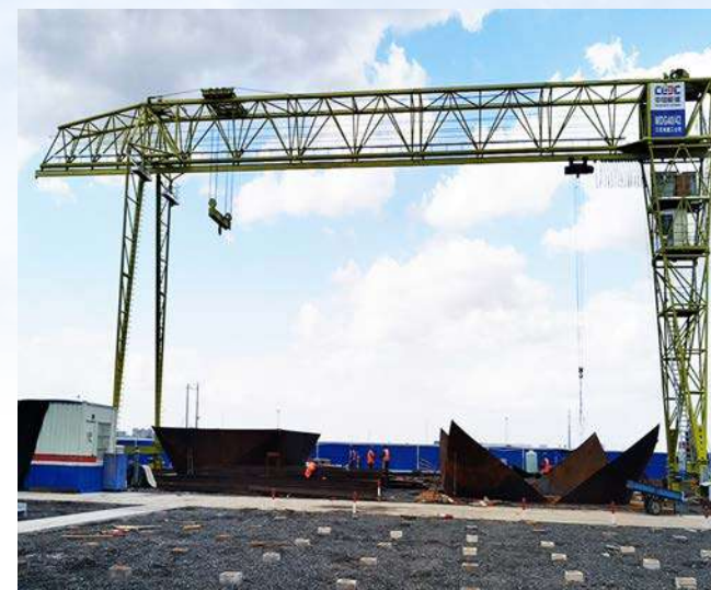
MDG门式起重机火电厂建设施工
