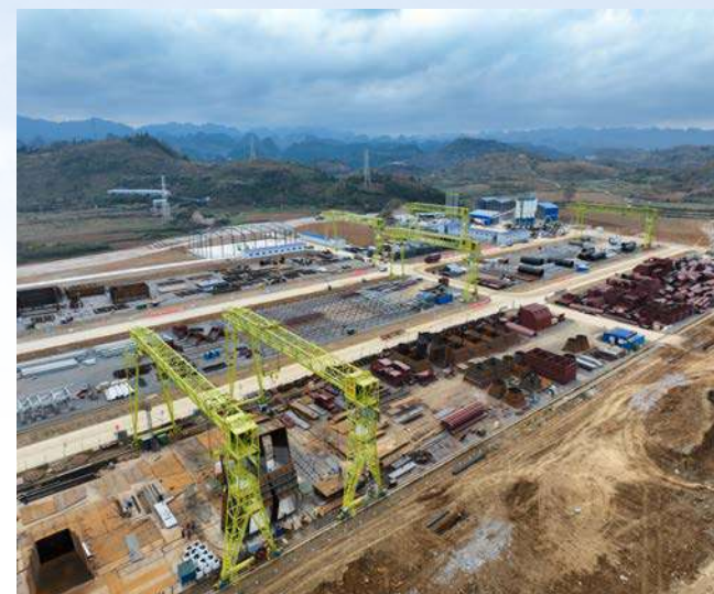
MDG门式起重机火电厂建设施工
