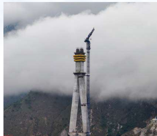
JLP系列平头塔机用于桥梁建设
