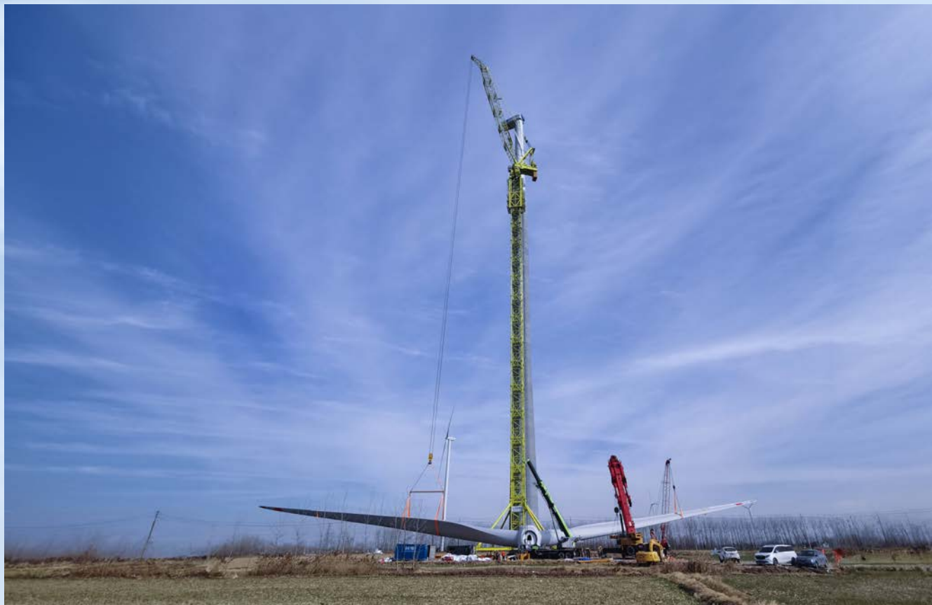
金利200t风电动臂塔机2023年用于全球最高5MW-180m风电吊装
