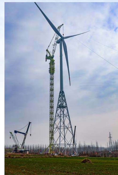
金利180t风电动臂塔机2021年用于国内最高4.5MW-160m桁架风电吊装
