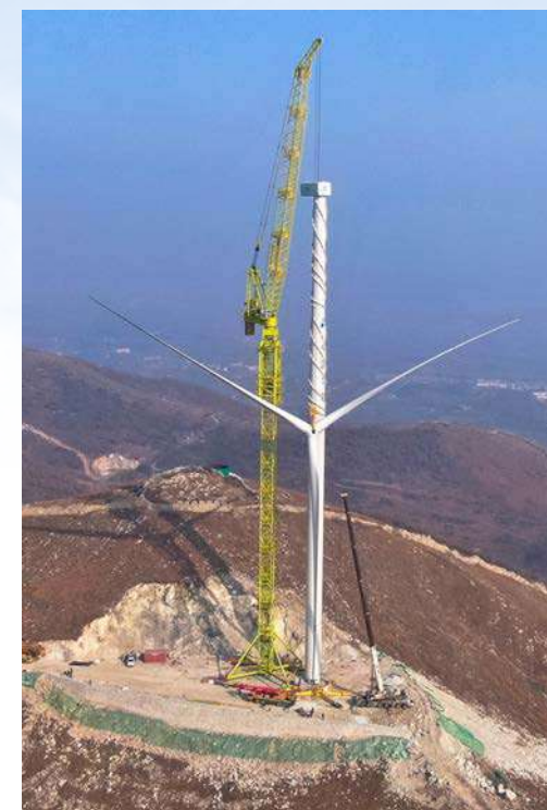
金利136t风电动臂塔机2019年用于国内最高2.2MW-130m山地风电吊装
