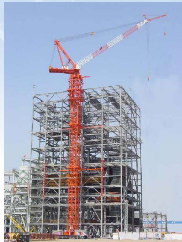
JLD系列动臂塔机进行火电机组施工
