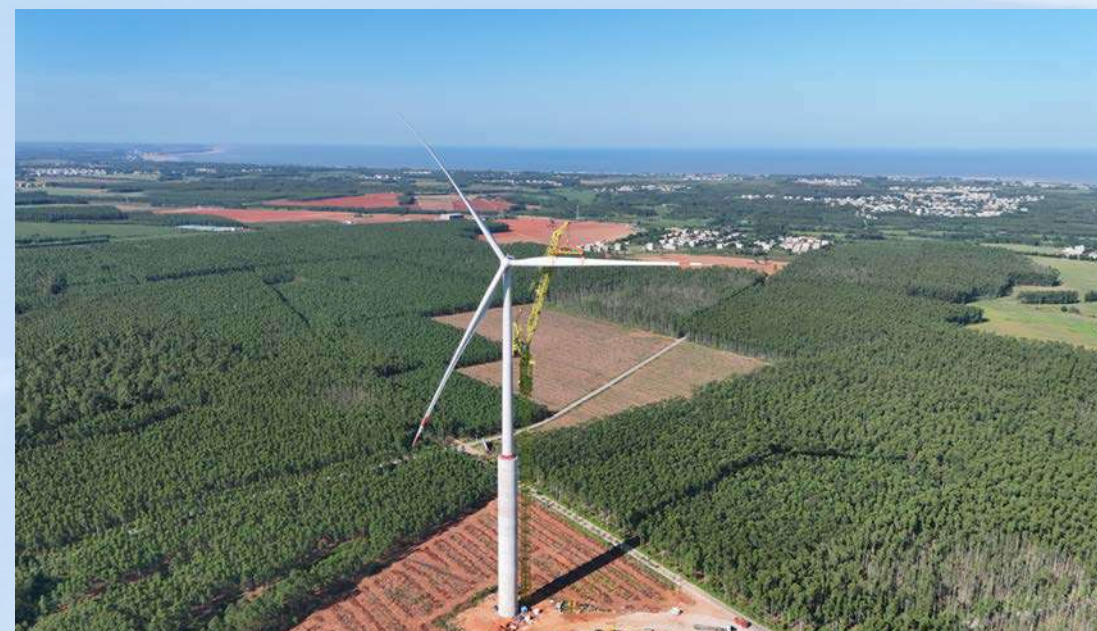
金利200t风电动臂塔机2024年用于全球最高5MW-185m风电吊装
