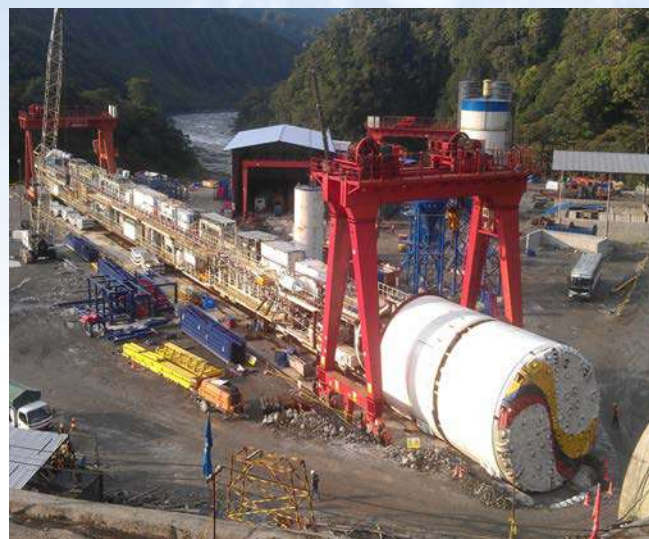
ME门式起重机地铁施工
