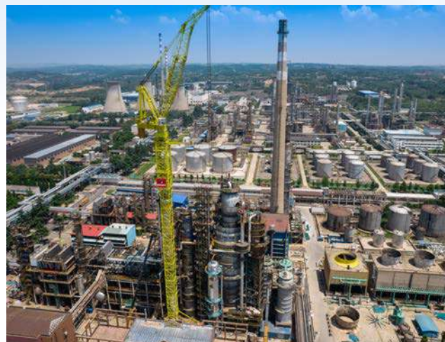
石化催化裂化装置更换
