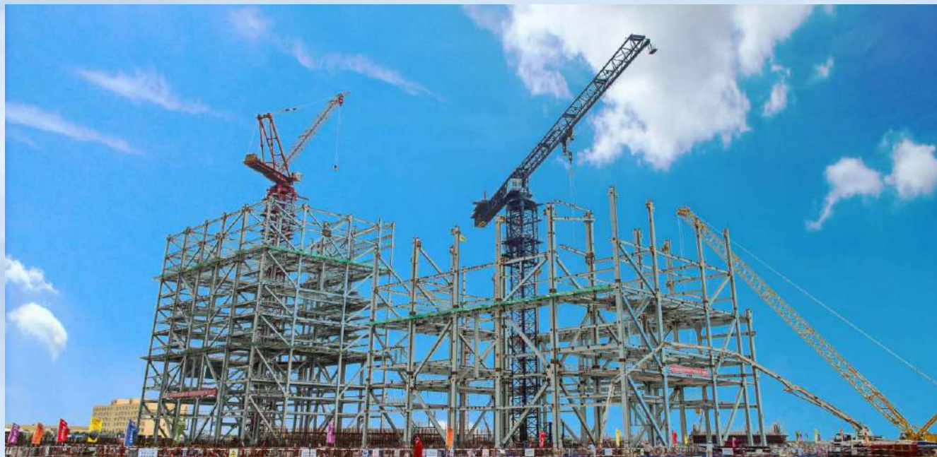
JLD系列动臂塔机与JLP系列平头塔机进行火电机组施工
