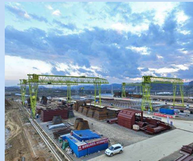
MDG门式起重机火电厂建设施工
