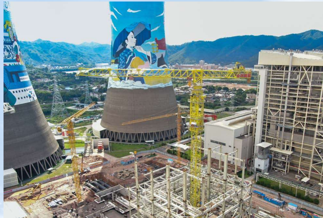
金利200t平头塔机2022年全球首创大底架型式应用于百万火电机组施工
