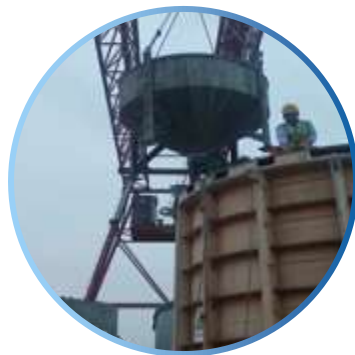
6.混凝土浇筑
