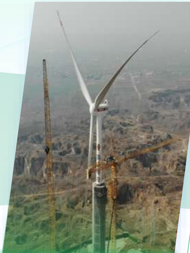
现浇分段直塔
