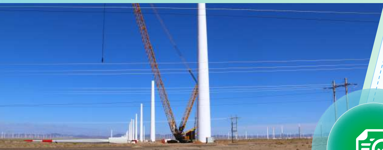
世界装机容量最大的，混凝土塔筒结构风电场
