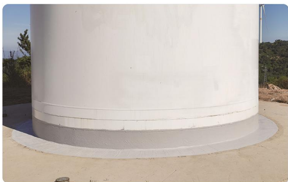
基础环基础聚氨酯防水
