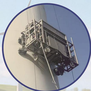
机器人风电塔筒清洗
