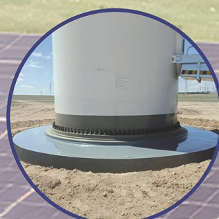
基础结构防水密封
