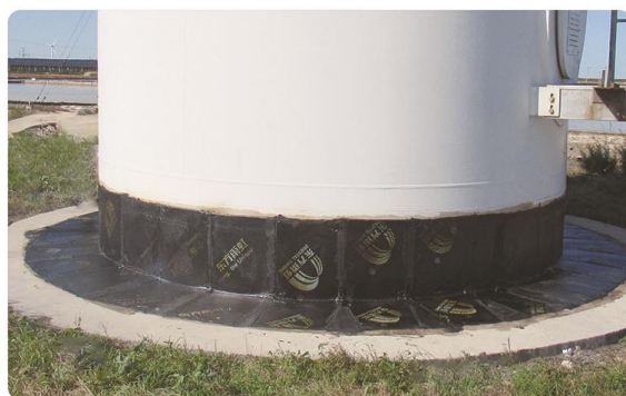
基础环基础卷材防水
