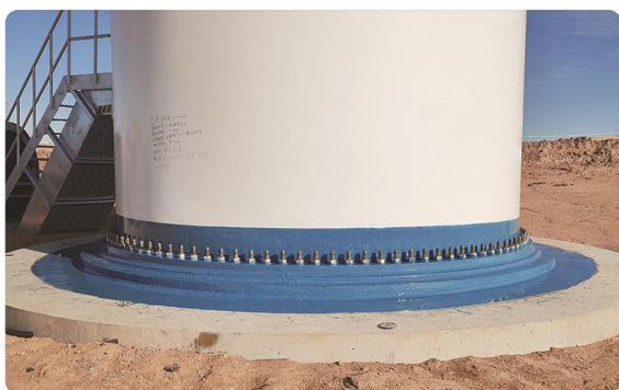
锚栓基础PMMA防水
