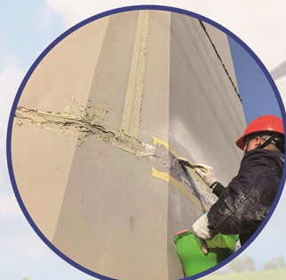
混凝土塔筒检测与维修
