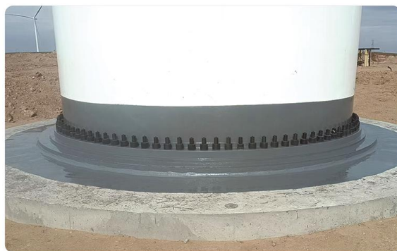
锚栓基础聚脲防水
