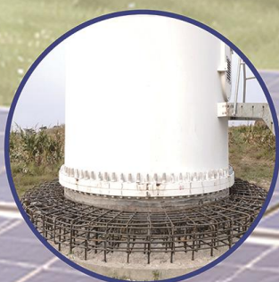
钢塔基础检测与加固
