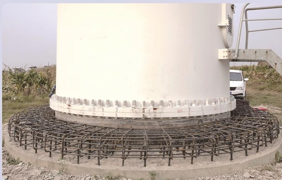
基础植筋锚固
