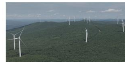
东宁18台机组雷电智能监测改造项目
