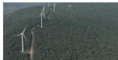
牡丹江18台机组雷电智能监测改造项目
