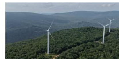
牡丹江2台机组雷电智能监测改造项目
