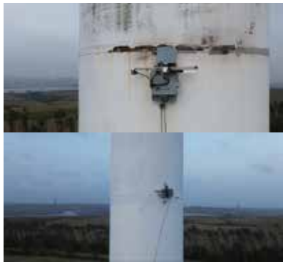
广东湛江某风电场防腐作业
