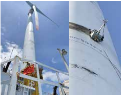
福建平潭某海上风电场防腐作业
