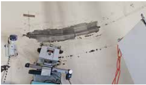
黑龙江大庆某风电场塔筒内部防腐作业
