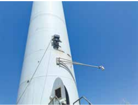
江苏盐城某风电场防腐作业
