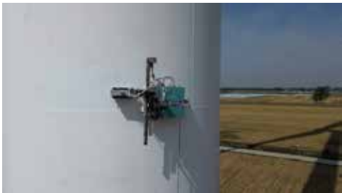
河南周口某风电场防腐作业
