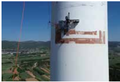
山东济南某风电场防腐作业
