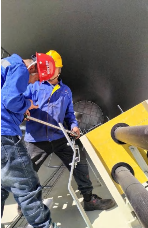
塔架厂的安装
