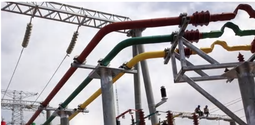
12kV/ 4000A 石油化工
