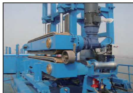
项目施工现场
