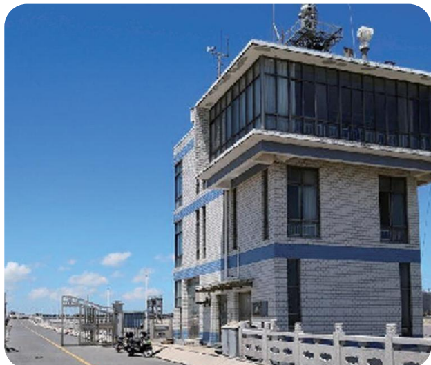
南通连兴港海洋环境观测站
