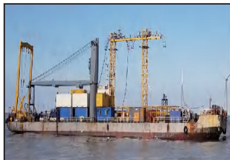
项目施工现场
