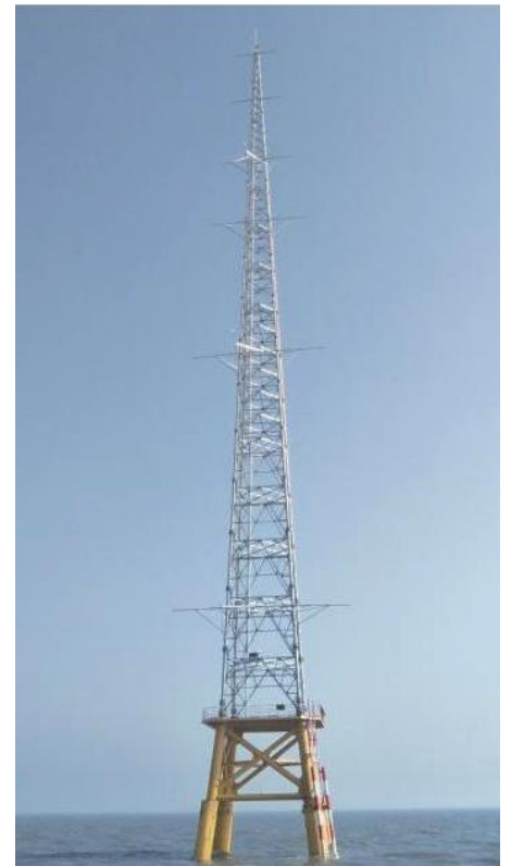
测风塔安装实景图
