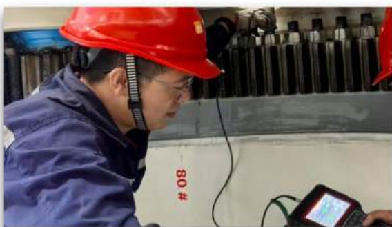
叶片 / 主轴螺栓故障处理
