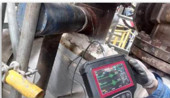
石油管道法兰螺栓测量
