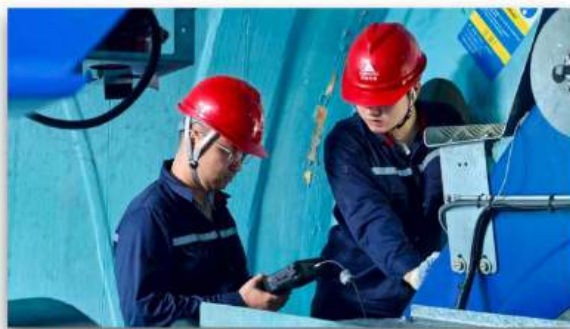
定期螺栓预紧力巡检
