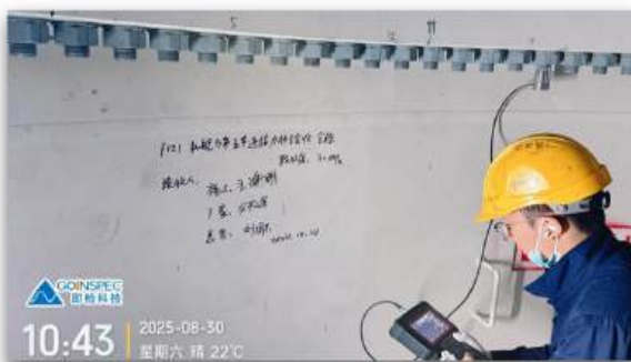
现场施工质量验收
