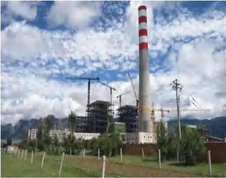
图4 项目现场图片
