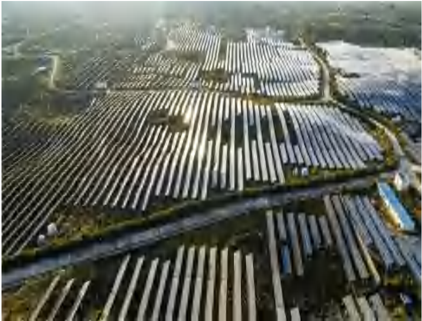
图3 本项目航拍图
