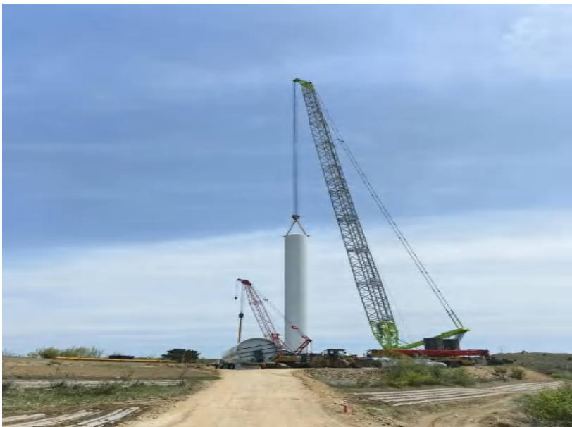
图8 项目施工现场
