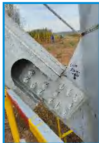
里岔1号机位 一层斜杆
