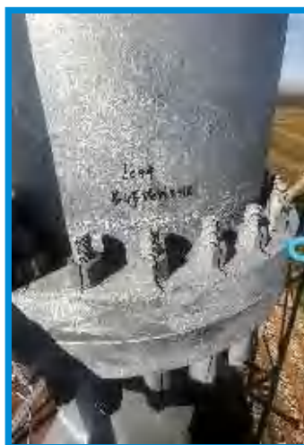
里岔4号机位 主柱
