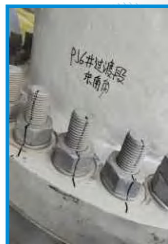
铺集6号机位 过滤段东南角
