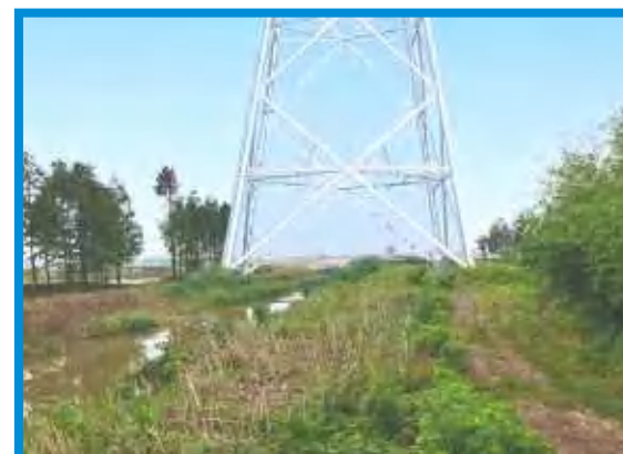
跨沟渠和生产道路
