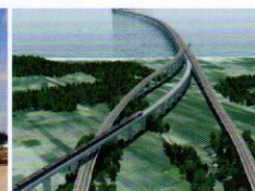
孟加拉PADMA大桥
