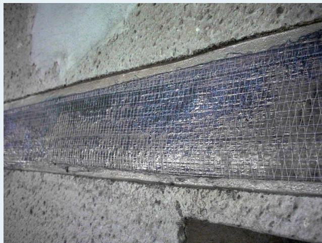
大型建筑缺陷修复
