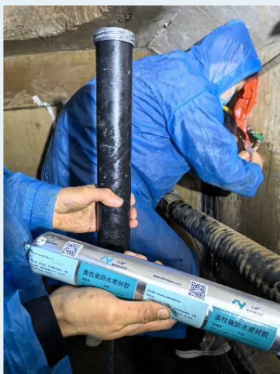
隧道防水堵漏工程
