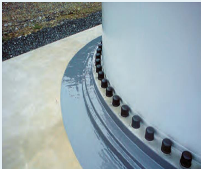
风电基础防水工程
