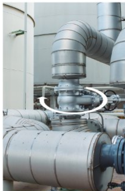
腐蚀环境 korrosive Umgebungen
